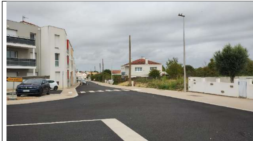
1- Rue des Paludiers depuis le carrefour avec la rue du Bardonneau
