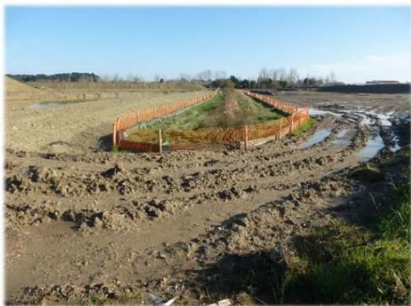
Figure 31 - Exemple de balisage de zones sensibles en phase chantier
