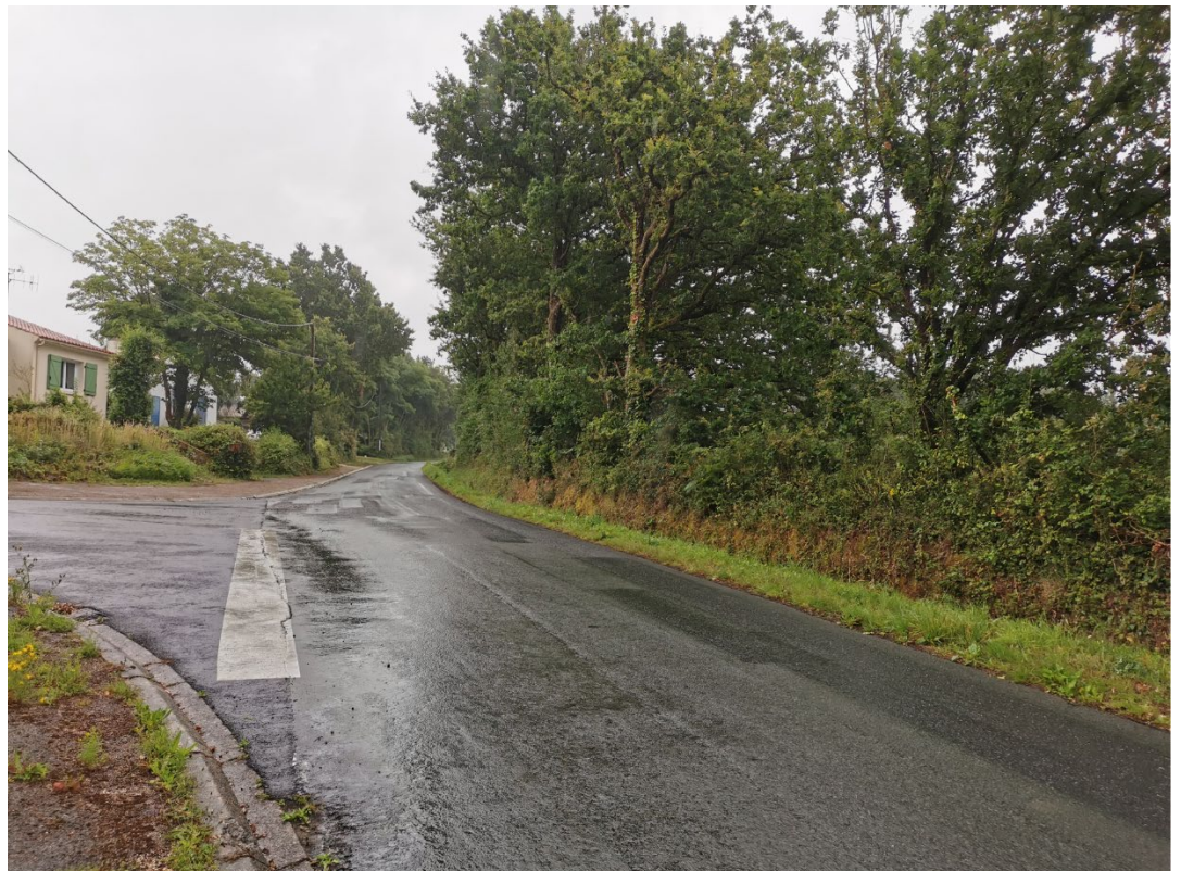
Rue des Moulins Vue vers le Sud-Est
